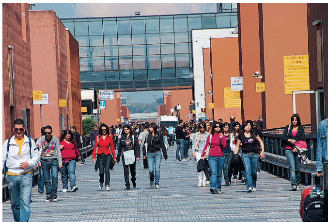
Il ponte "Pietro Bucci", elemento architettonico caratteristico dell'Ateneo
